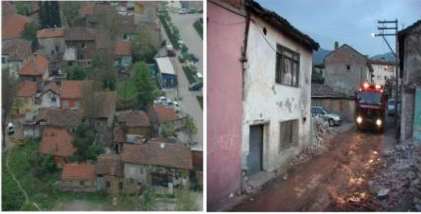
Şekil 2: Doğanbey Kentsel Dönüşüm Projesi Öncesi Doğanbey Mahallesi Görünümü (Kaynak: Bursa Osmangazi Kent Konseyi Fotoğraf Albümü, 2018)
