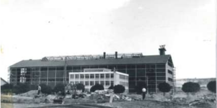
Şekil 3. Ankara Şeker Fabrikası (Kaynak: TOBB ETÜ Mimarlık Bölümü Arşivi)
