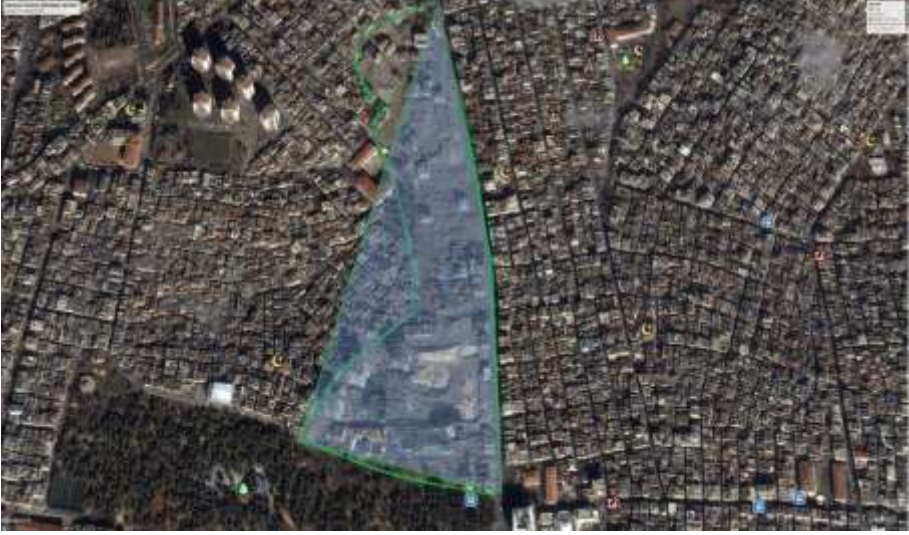
Resim 2. Nuri Pazarbaşı Mahallesi Kentsel dönüşüm uygulama esnasında(2009)
