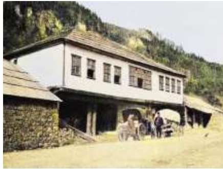
Şekil 3: Hamsiköy eski konak yapısı (Kaynak:
