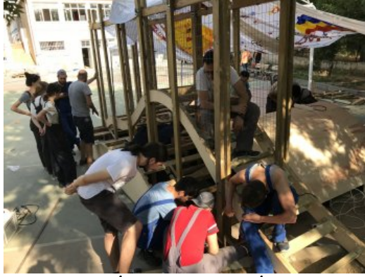
Hayallere Köprü (2015, İstanbul-Ayazađa İlköğretim Okulu) (url-7)
