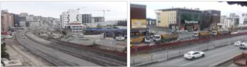
Şekil 7. Kaşıüstü kavşağı projesinde inşaat faaliyetleri (Kasım 2018 tarihine ait saha çalışması fotoğraflarıdır)
