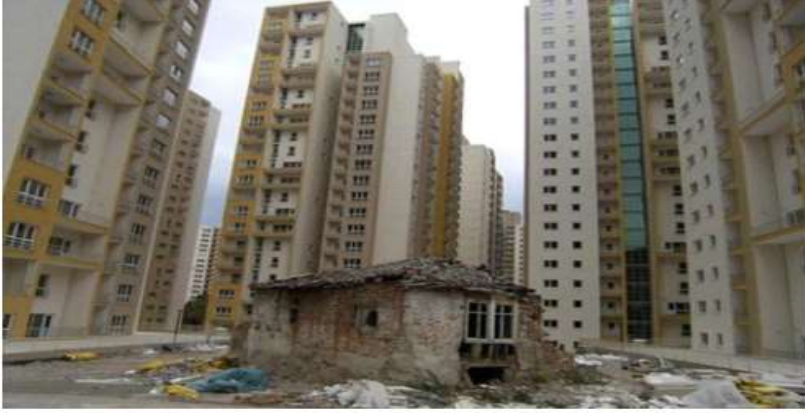
Şekil 3: Doğanbey Kentsel Dönüşüm Projesi Çok Katlı Konutların İnşaat Alanı (Tarihi Hamamın İnşaat Alanındaki Görünümü) (Kaynak: Bursa Osmangazi Kent Konseyi Fotoğraf Albümü, 2018)
