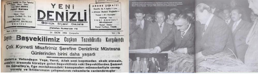
Şekil 4. Denizli Sümerbank İplik Fabrikası'nı ek bina için yapılan temel atma töreni, 22 Eylül 1956 (Kaynak: Yeni Denizli Gazetesi Arşivi; İnan, 2007, s.32-33)
