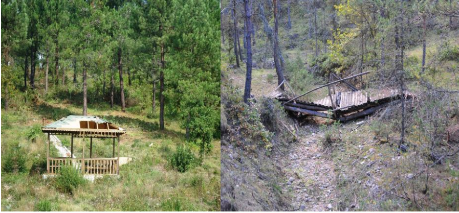
Şekil 4. Bakımsızlıktan zamanla yıkılan yapılar (Bartın ve Kastamonu kent ormanları)
