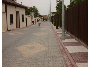
Arslantepe Giriş güzergahındaki sokak
