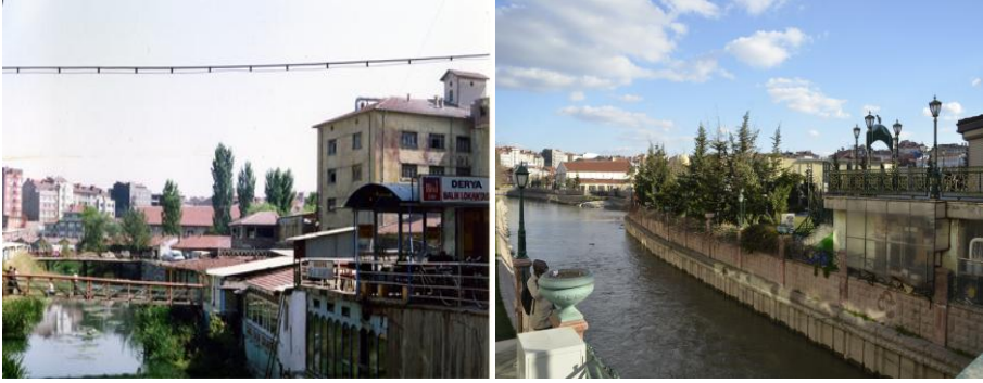
Resim 6. Çukur Çarşı'nın 1993'de çekilmiş bir fotoğrafı**; köprüleri, kestirmeleri, arkadaki Un Fabrikası yıkılmadan önceki durumu ve 2015 aynı yerden son düzenleme sonrası görünümü*.
